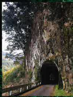
田口線双瀬トンネル
