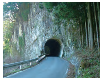
(双瀬トンネル)
