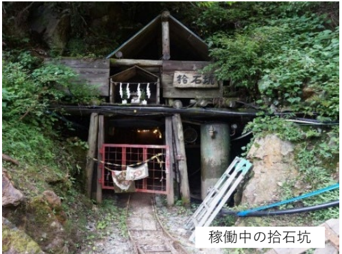
採掘・掘進中の坑内
